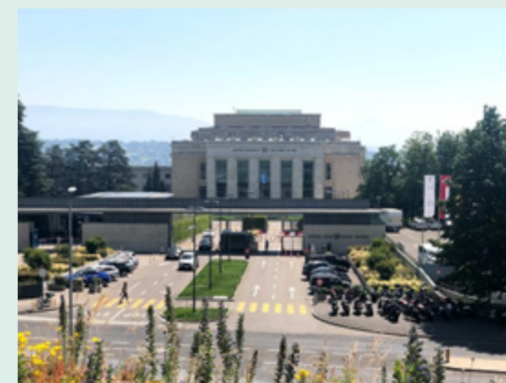
Vue de l'entrée dénommée Pregny Gate à l'Office des Nations Unies à Genève, montrant son bâtiment principal. Il y a au premier plan une route avec des voitures et des motos, entourées de verdure
